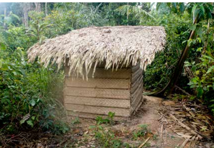
Banheiro sem água corrente, comunidade Cristo Redentor, igarapé Miriti, 2019.
