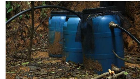
**Imagem 07.** Sistema de captação e filtragem de água da **tekoa** Kuaray Haxa
